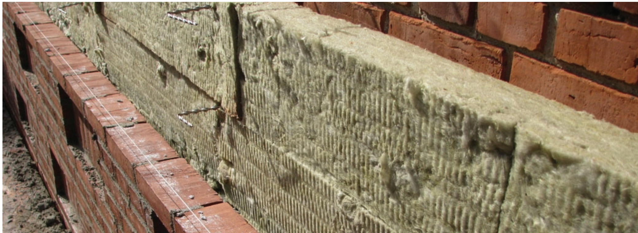
Eksempler på udvendig efterisolering
